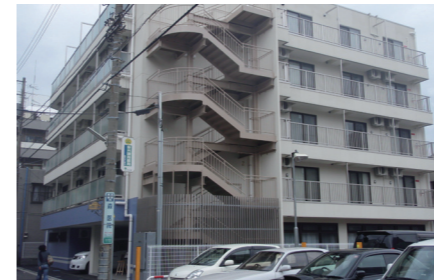
老人ホームの屋上・外壁に塗布。
