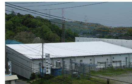
冷蔵倉庫屋根に塗布。
