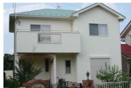
S邸：塗布箇所/屋根：94㎡、外壁：140㎡。
