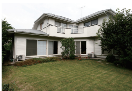
M邸：塗布箇所/屋根：130㎡、外壁：140㎡。
