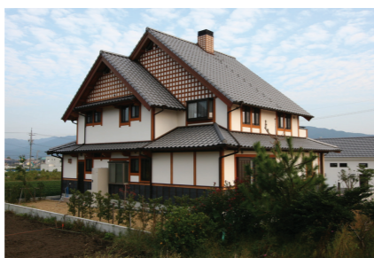
T邸：塗布箇所/屋根：300㎡、外壁：180㎡他。
