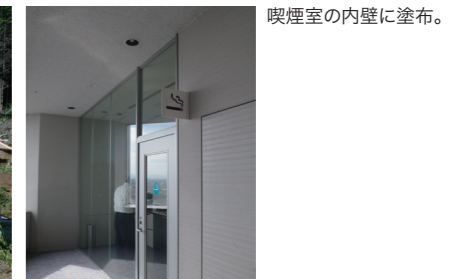
喫煙室の内壁に塗布。
