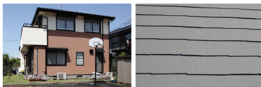
O邸：塗布箇所/屋根：90.9㎡、外壁：156.95㎡。
