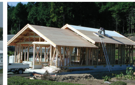
瓦屋根家屋の野地板に塗布。
