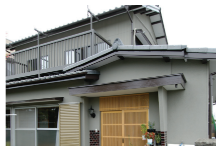
K邸：塗布箇所/内壁・天井：40㎡、外壁：260㎡。
